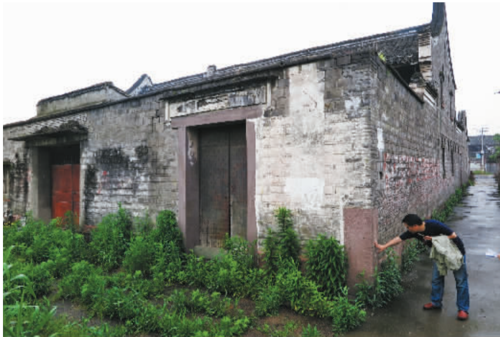
保存完好的古建筑墙角的石板上写着:石福房东边南首墙外留余地四尺砌傍。 记者 胡龙召 摄
