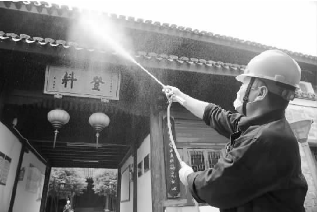
白蚁防治专家在它山堰一古建筑喷粉灭杀白蚁。 记者 胡龙召 摄
