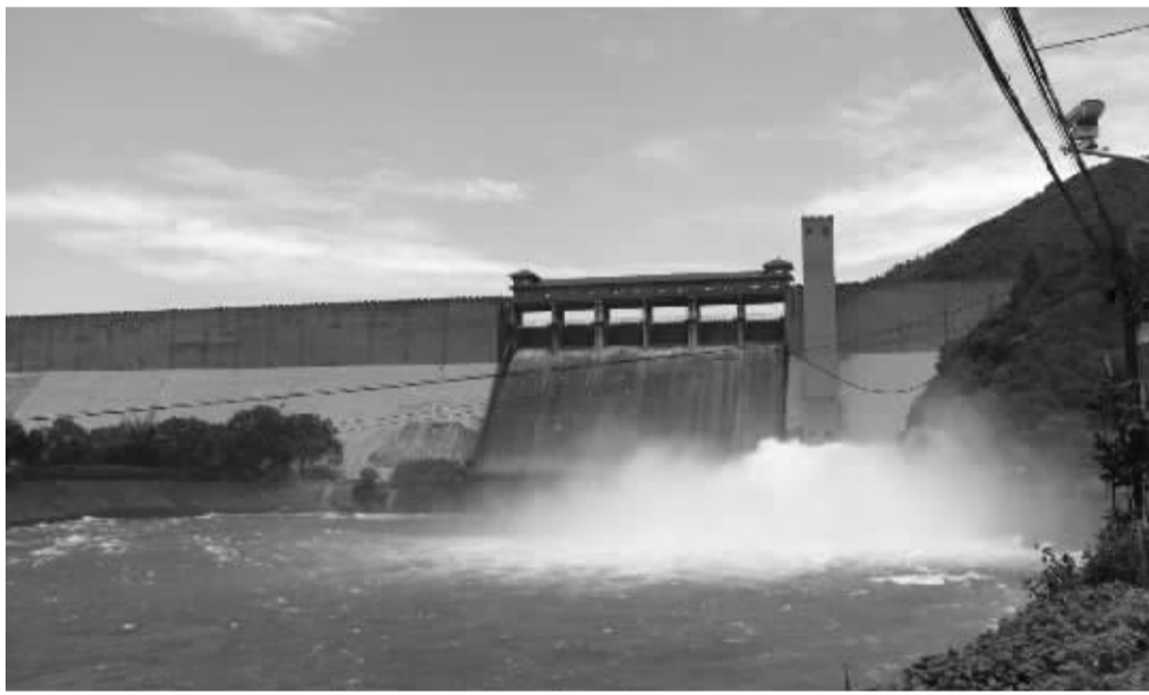
皎口水库开闸泄洪。 通讯员供图
