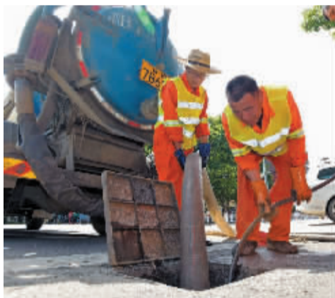
疏通地下雨污水管,确保排水通畅。
