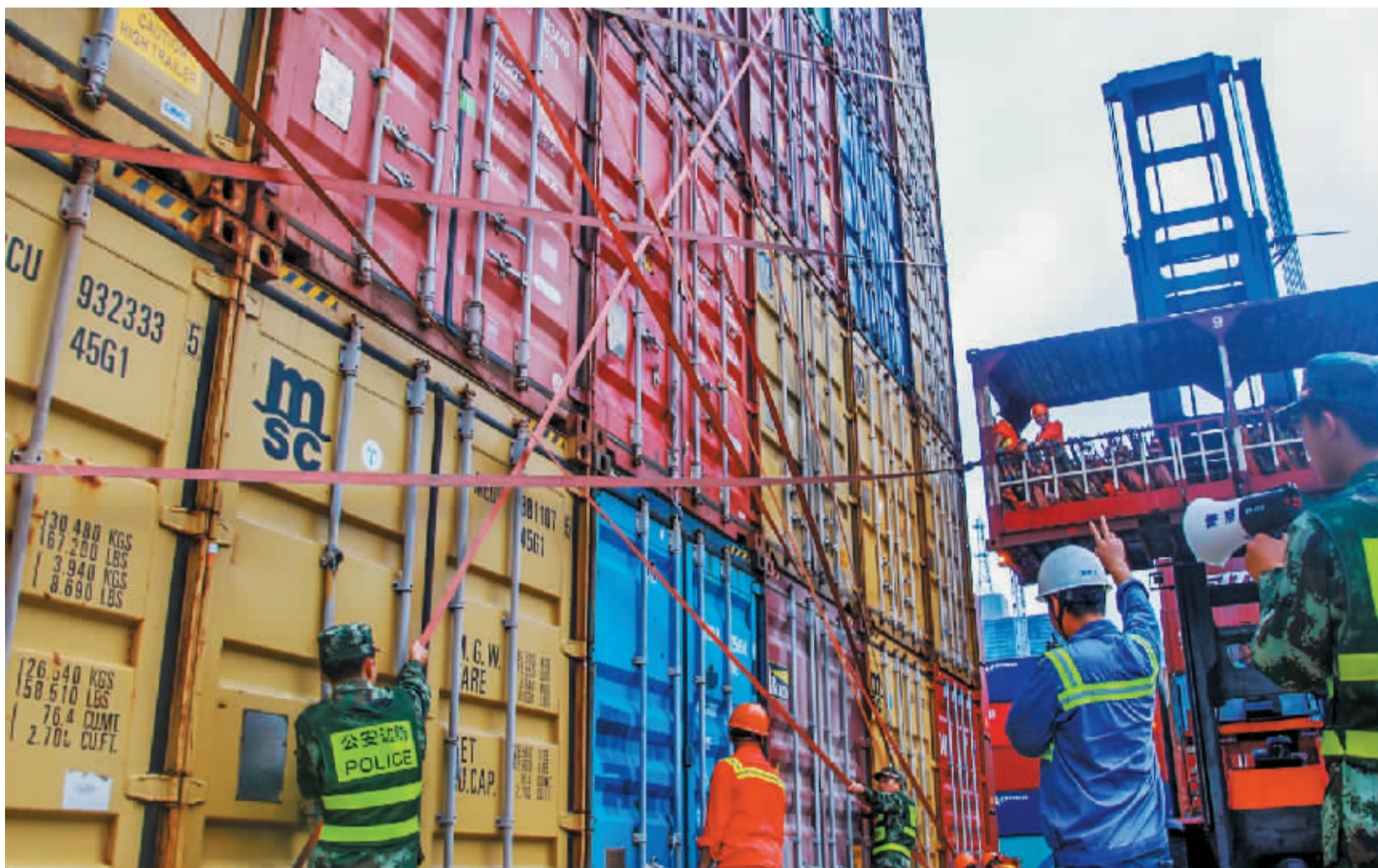
码头工作人员在加固空置的集装箱,做好强台风防御工作。
