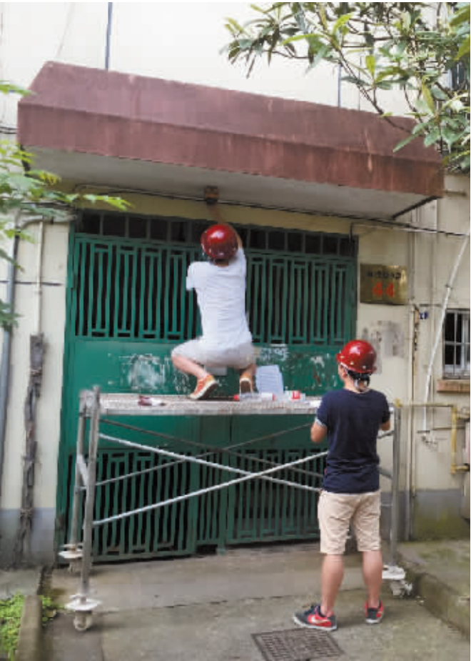
工作人员对南雅新村雨檐进行检测。 记者 张明强 摄
