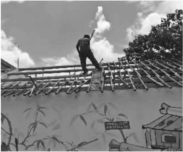
拆违现场。 记者 边城雨 摄
