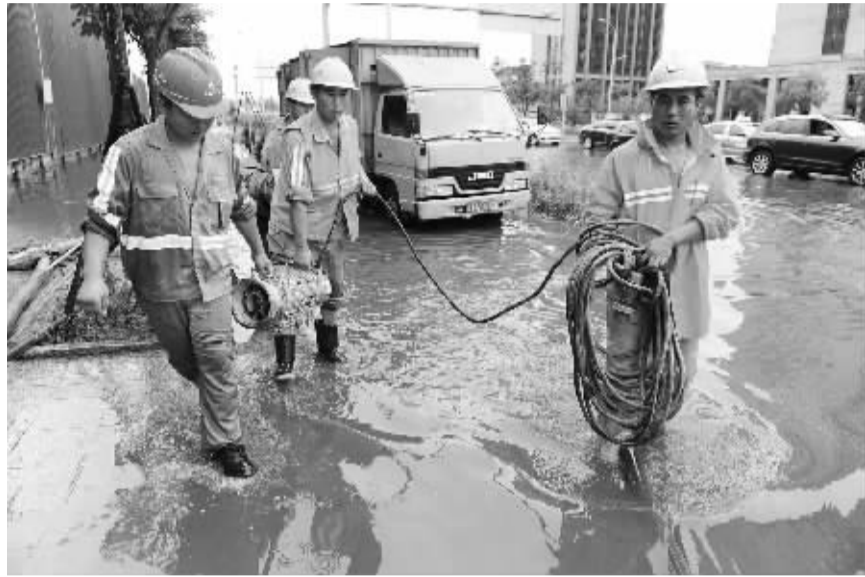
前天,鄞州排水工人街头排除积水。
