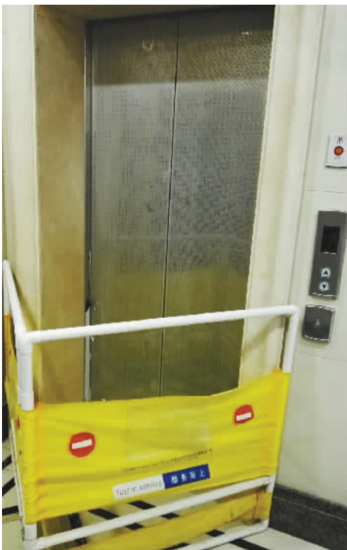
电梯出故障,暂停使用
