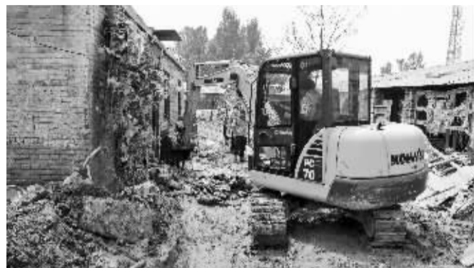
7月25日，挖掘机在邢台市开发区大贤村清理淤泥。
