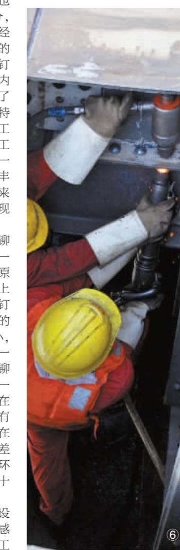
烧钉、抛钉、穿钉、顶钉、铆钉，这五个动作要在15秒内一气呵成。为尽可能保持灵桥原有的外观，要在原来的钉孔上进行重新铆钉，这需要先将钉子烧红至1200℃左右。灵桥的结构特殊，内部施工空间狭小，要在小小的空间完成铆钉等一系列动作非常困难。在内部铆钉的时候，我们只有稍微瘦一点的人才能进去，人刚好卡在里面，不能回头，不能转身，有的人干一天，一下工就累瘫在地上，但是却没有出过一丝差错。就是在这样艰苦的施工环境下，我们一共为灵桥铆了十万多个钉子。
