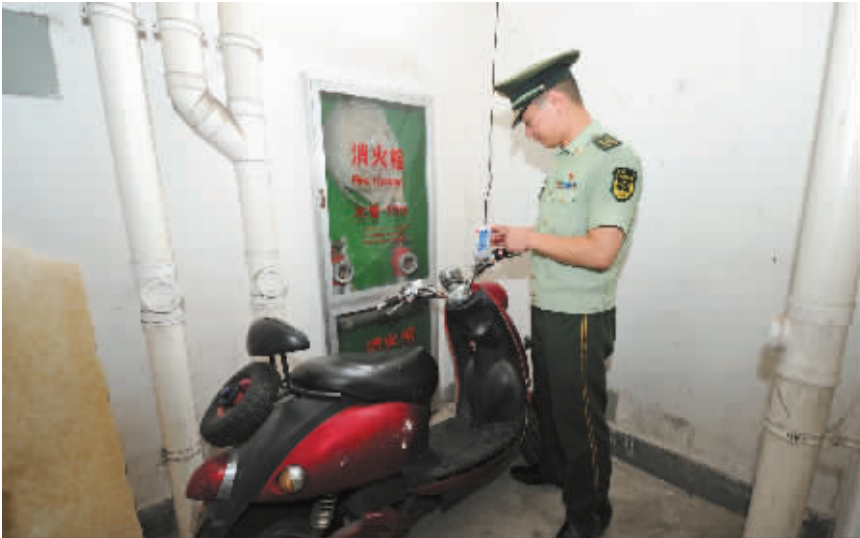
一辆电瓶车遮挡住了消火栓。 记者 马涛 摄
