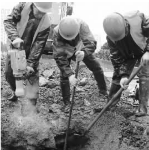
年前强寒潮中,市供排水集团抢修冻裂供水管道。 通讯员供图
