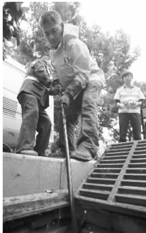
供排水职工疏通堵塞的排水管道。
