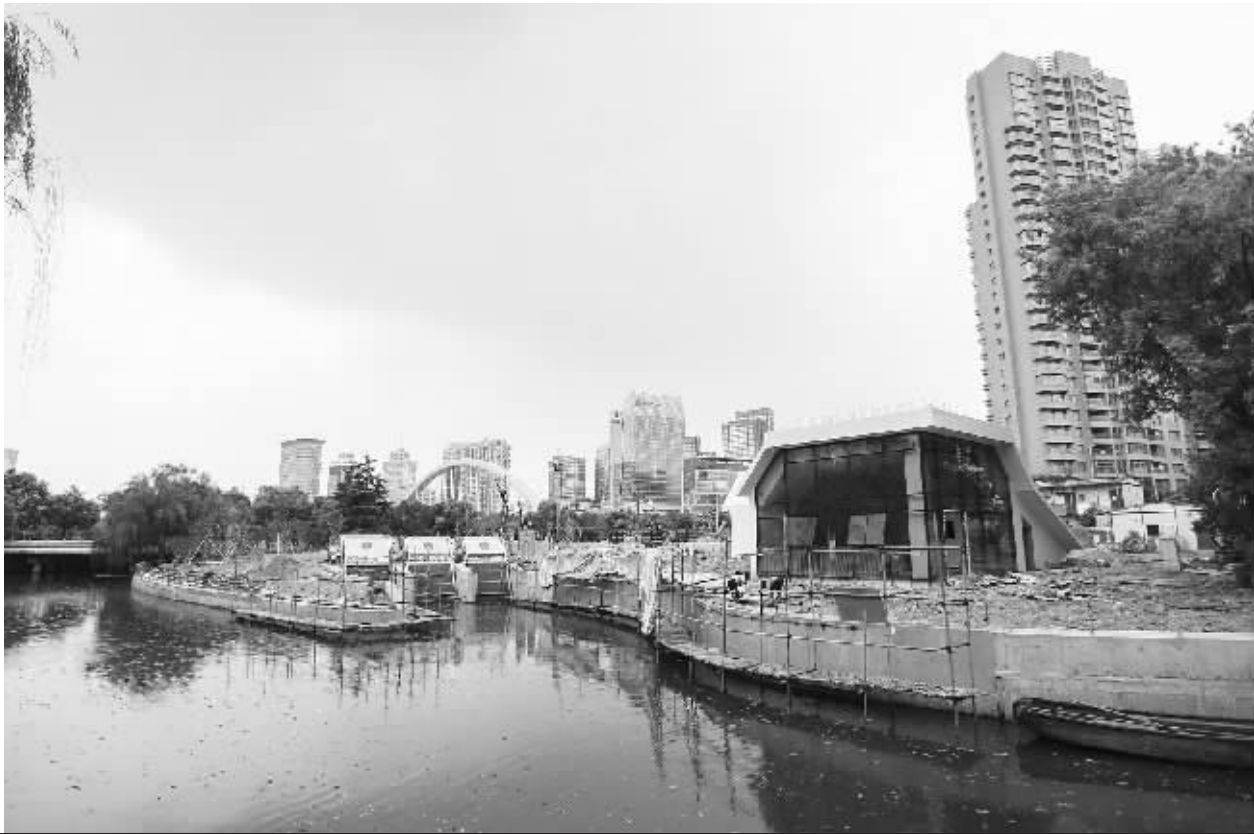
建设中的大石窰泵。
