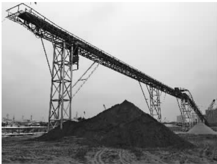
拆迁地块上建起的无证沙场。
