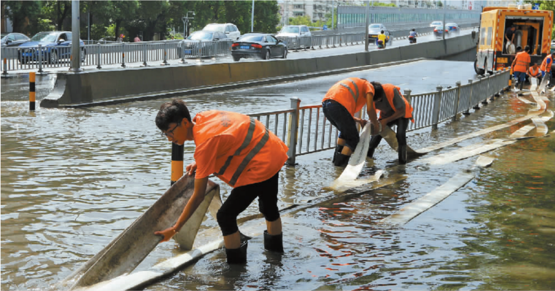
▲工作人员正在积水点准备排除积水。 记者 周建平 摄
