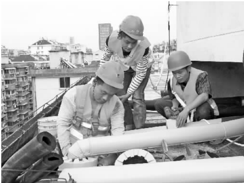
供水工作人员正在施工。
