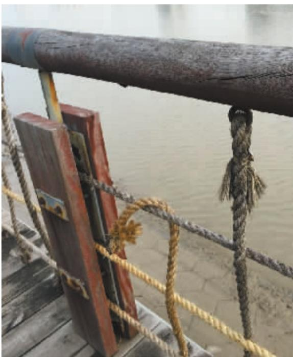
此处的麻绳一条断裂，另一条已经腐烂。
