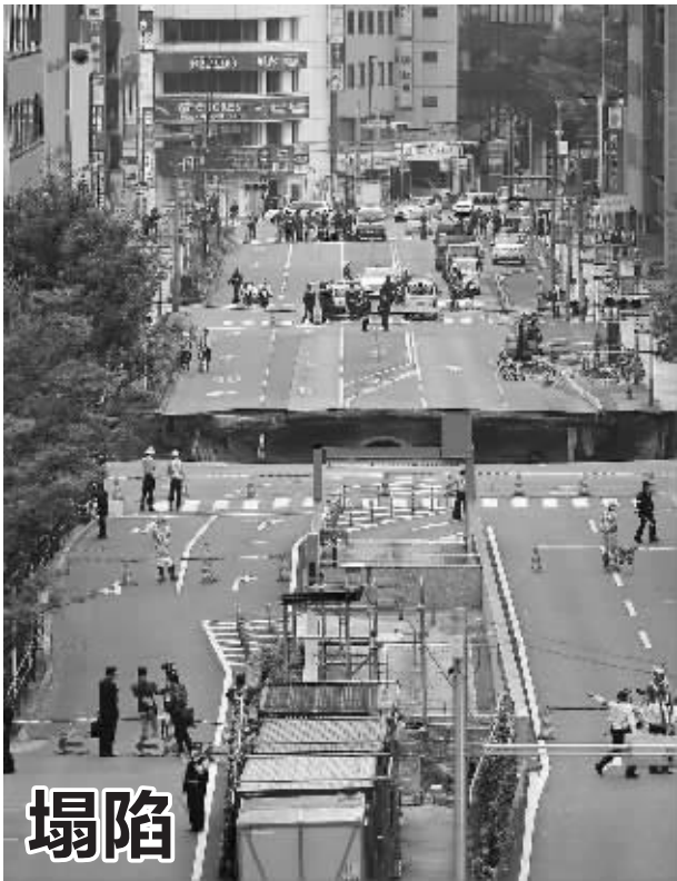
这是11月8日在日本福岡拍摄的地面塌陷形成的大坑。当日,日本西南部城市福岡的一处路面发生塌陷,事故未造成人员伤亡。 新华社
