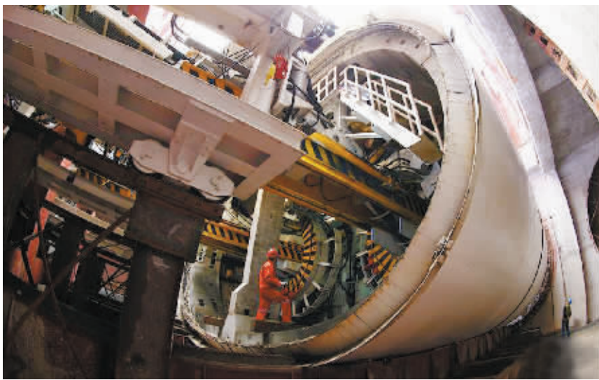
2015年11月30日，“阳明号”盾构机在宁波轨道交通3号线一期工程现场施工。
