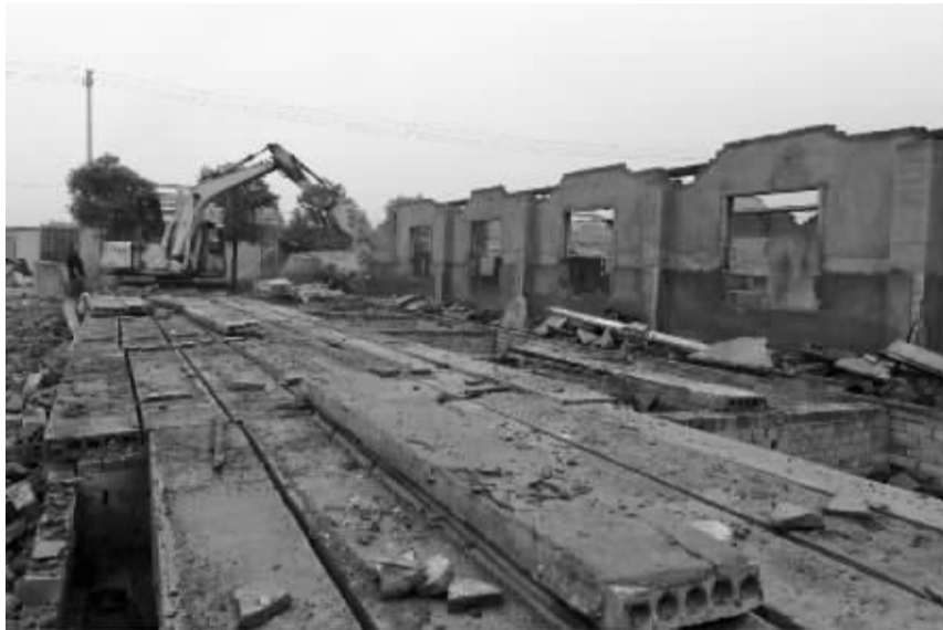
养殖场被拆除现场。
