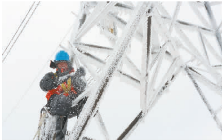
登上铁塔检查观冰器。柴铮 摄
