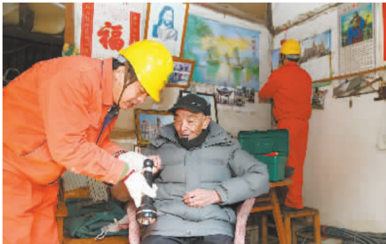
为空巢老人检修线路。邬晓刚 摄
