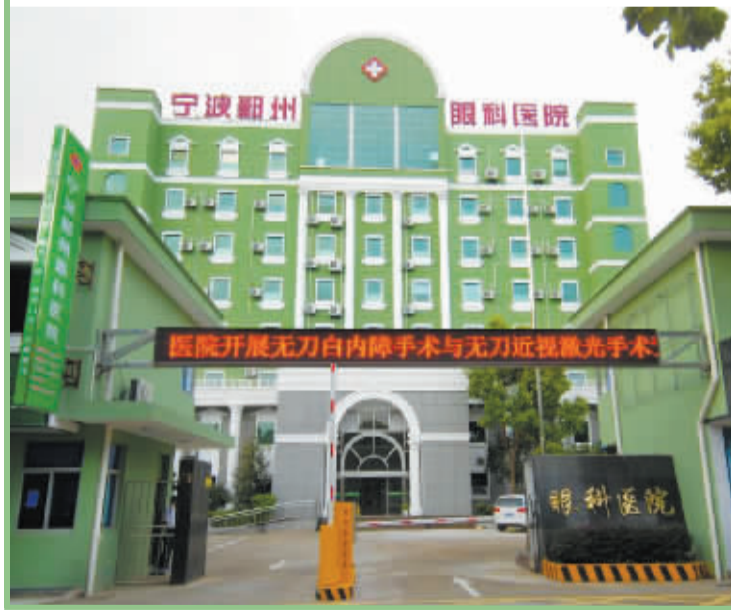
宁波鄞州眼科医院主楼外观。
