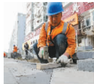
石板严格按照精细化要求铺装。
