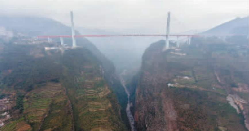
“一桥跨云贵,天堑变通途。”横跨云贵两省、高达565米(相当于约200层楼高)的北盘江大桥29日上午正式通车,云南与贵州之间又一条高速公路实现贯通。 新华社发
