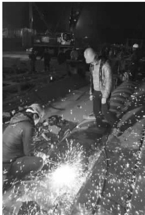
工作人员正在抢修水管。记者 边城雨 摄
