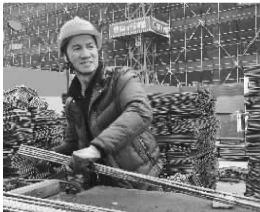
张万海在工地准备安装钢筋。通讯员供图
