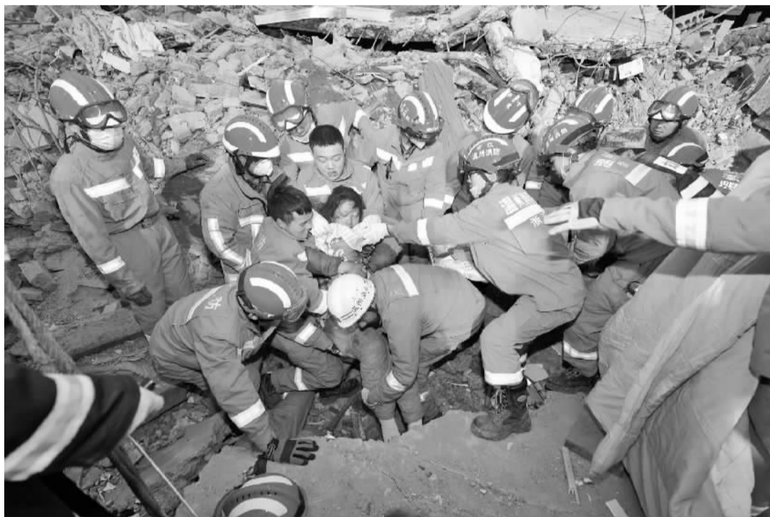
2月3日清晨,在浙江温州文成民房倒塌事故现场,救援人员救出第二名幸存者。 新华社发
