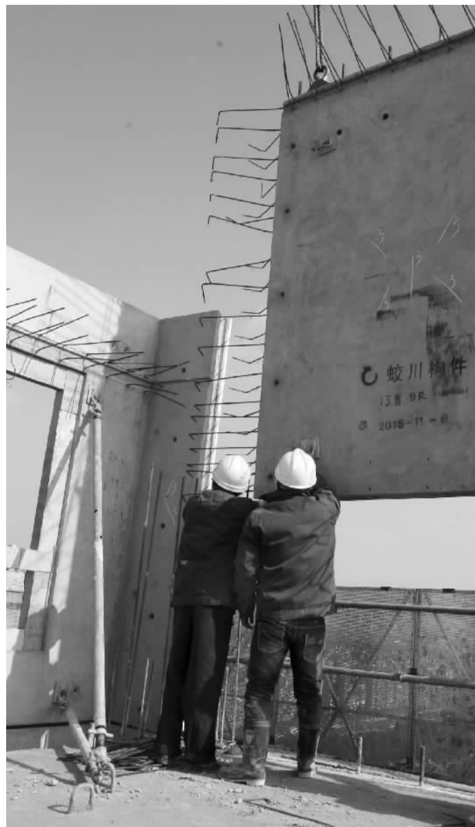
装配式建筑施工现场 记者 刘波 摄
