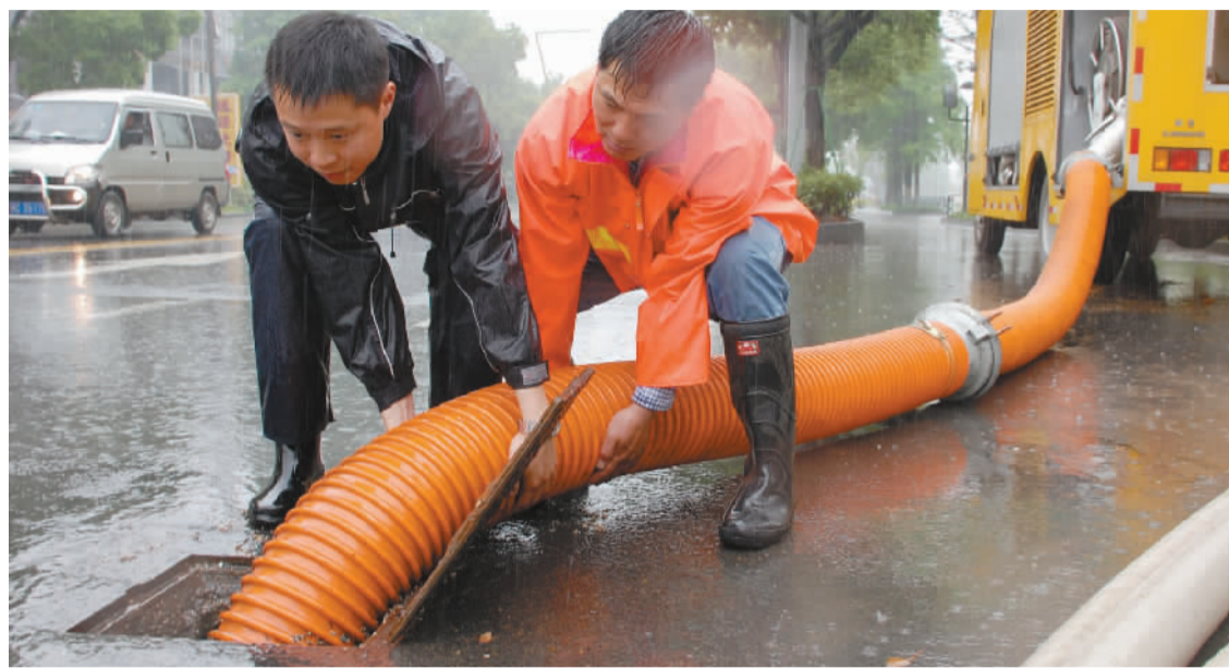
抢修人员紧急强排道路积水。
