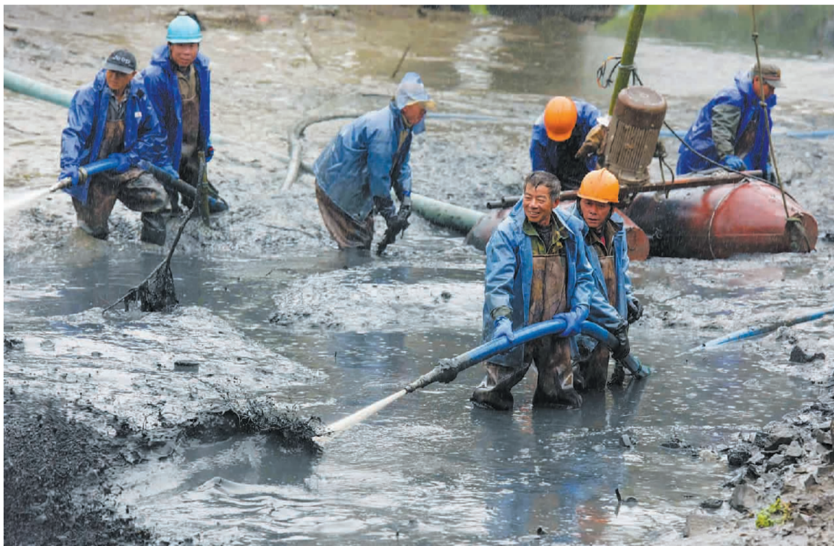
昨天，工人们抓紧时间对位于镇海区骆驼街道的五星河进行河道清淤疏通作业。据了解，五星河是镇海区区级河道，主要用于防洪排涝及沿河农田的灌溉，该河道预计于4月底完成整治工作。 记者 徐文杰 通讯员 陆金妹 摄
