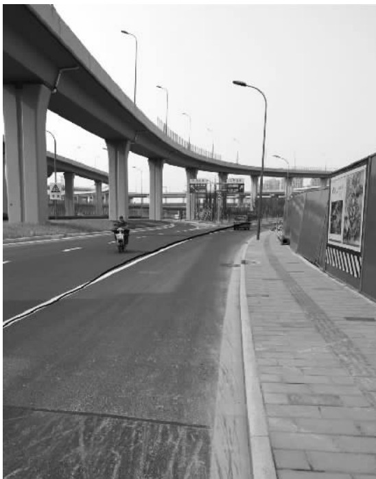
机场路北环西路枢纽路段,非机动车与机动车争道。
