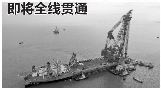
5月2日13时许,伶仃洋上,"振华30"起重船吊 起重约6000吨的最终接头(上图),像"楔子"一样将 海底隧道连为一体,这意味着迄今世界最长跨海大 一港珠澳大桥主体工程即将全线贯通。
