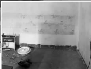
改造前的房间。
