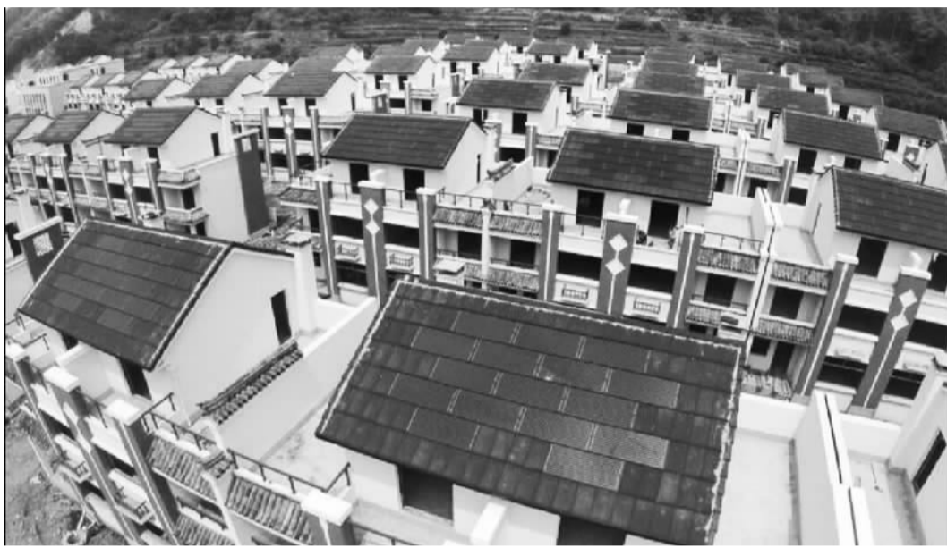
►海曙区龙观乡李岙村光伏屋顶。
