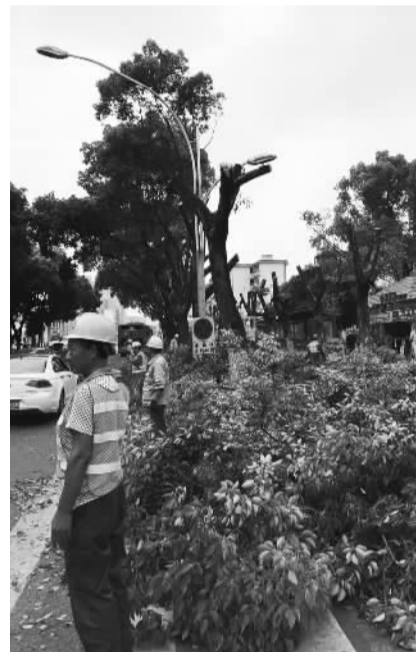
施工人员正在移植树木。
