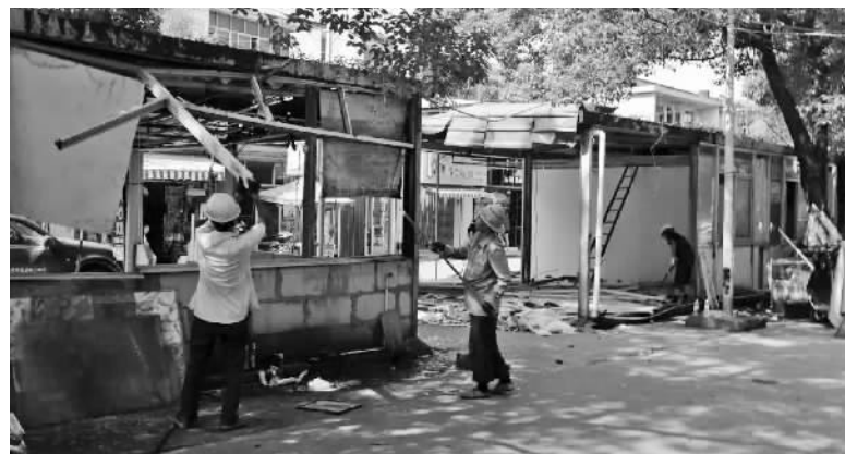
工作人员正在拆除马路市场。
