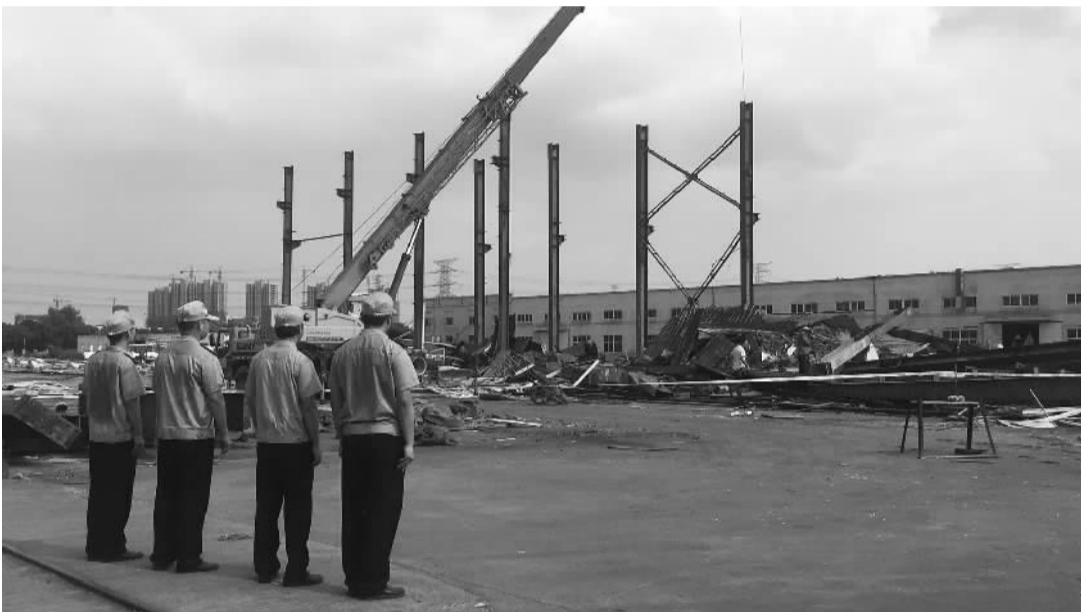
7月14日,宁波东隆钢构有限公司的违建被拆除。 记者 边城雨 摄
