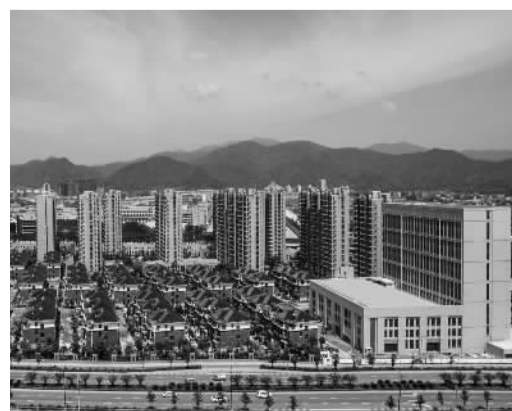
宁海桥下潘棚改安置
