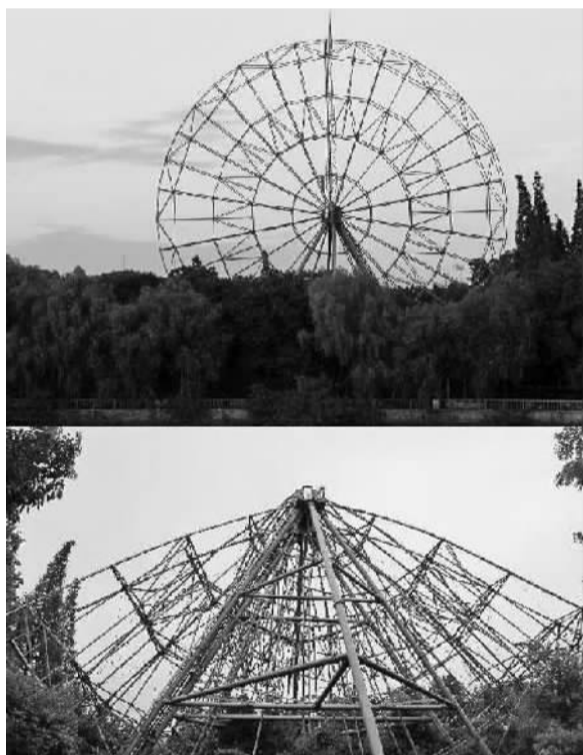
宁波绿岛公园内摩天轮在2012年8月8日被“海葵”台风吹断,这是台风前后对比图。(图片来自网络)
