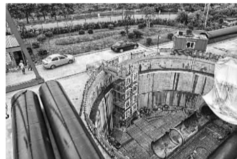
顶管贯通施工现场。
