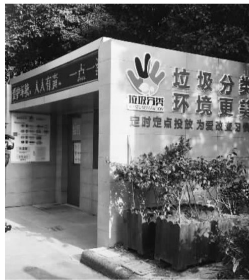
改造后的垃圾房。
