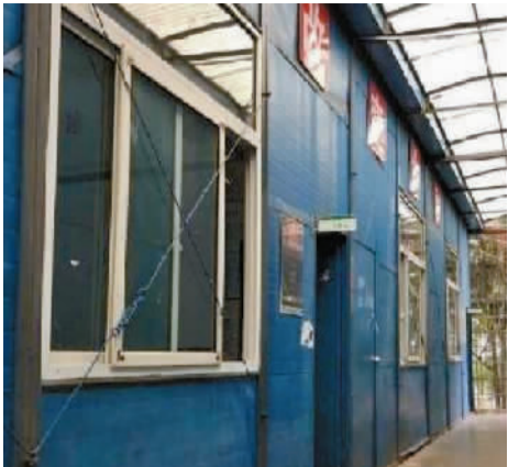
遭学生吐槽的“集装箱教室”
