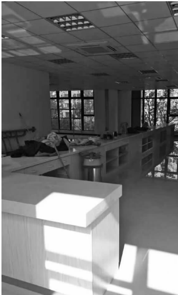
正在装修的社区办公用房内景。受访者供图
