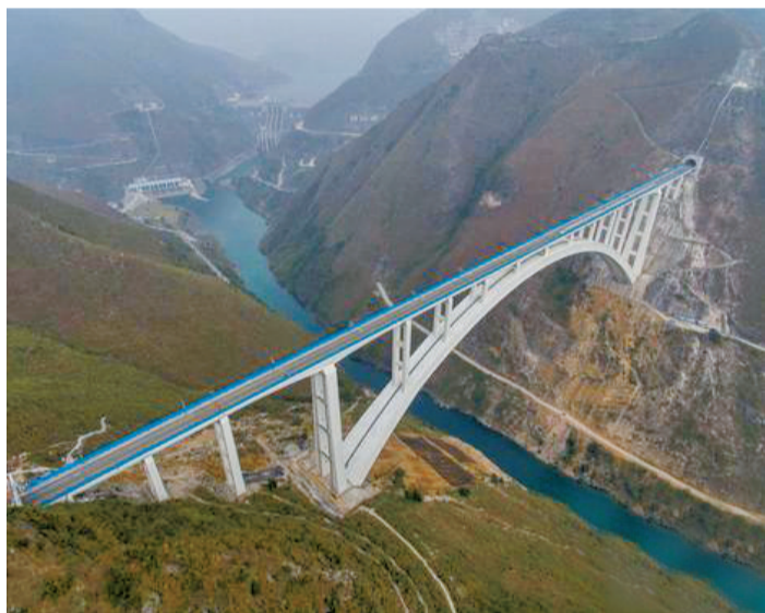
中国高铁最大跨度桥梁——北盘江特大桥两侧隧道渗水严重。
