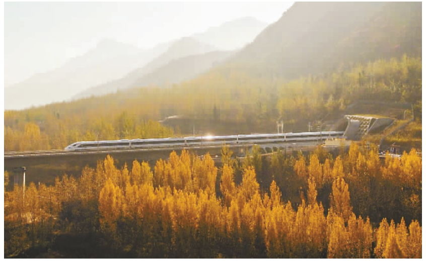
动车组试验列车驶过西成高铁位于关中平原的一座铁路大桥(11月26日摄)。
