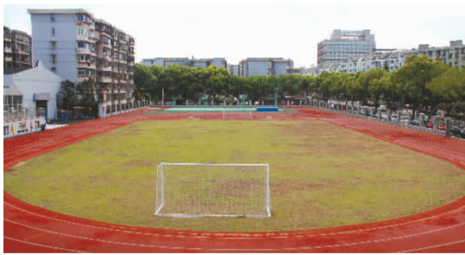
鄞州曙光中学在拆后场地上新建200米非标跑道。资料图片
