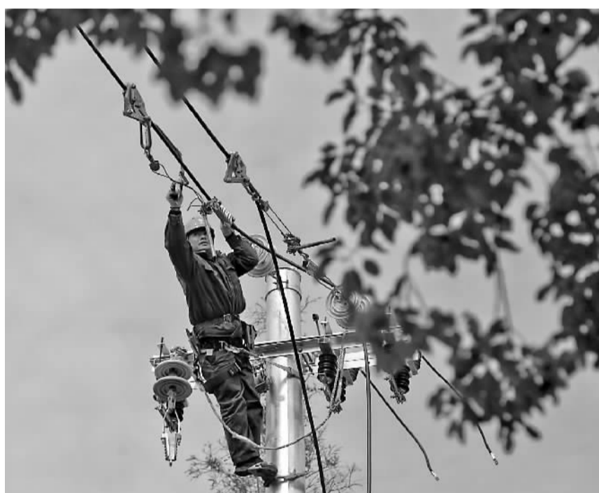
电力工人在施工。
