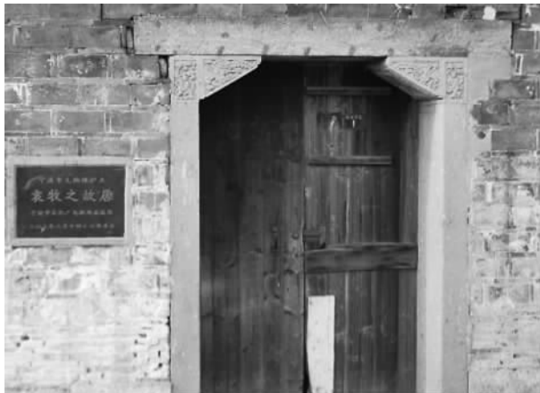
袁牧之先生故居位于宁波海曙区杨家桥1号(南塘老街),为典型的清晚期木结构建筑,布局呈传统的三合院式,主体建筑坐北朝南。主楼为五间二弄重檐硬山式楼房;前檐柱上有十字斗拱,前檐廊有月梁,前端呈象鼻状;厢房为两开间硬山式平房,建筑保存完整。
