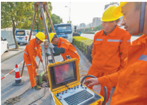
工人正在操作管道机器人。
